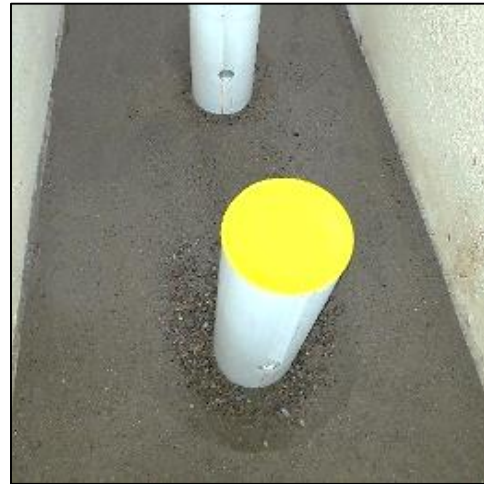
الشكل (5) يوضح تجمع الحبيبات الاخشنة للتربة بعد مرور زمن الاستقرار
