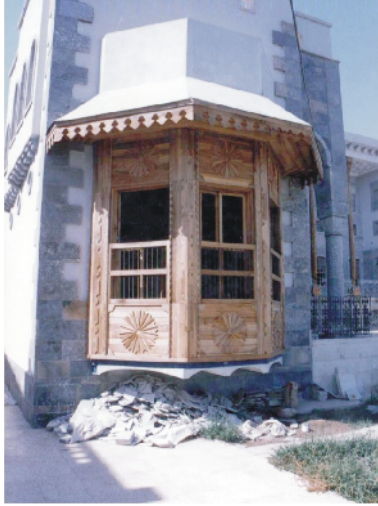
شكل رقم (13): الكوش الخشبي (الخارجي) المصنوع من خشب التوت المحلي (المصدر: الباحث).
