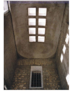
شكل رقم (17): فتحات الأضواء والتهوية في سقف المجاز (المصدر: الباحث).
