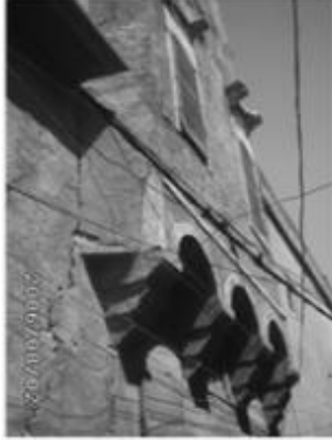
كوابيل- تداخل العناصر الإنشائية مع الزخارف المطلة على الزقاق التقليدي لتكوين ظلال إضافية/ الموصل القديمة
